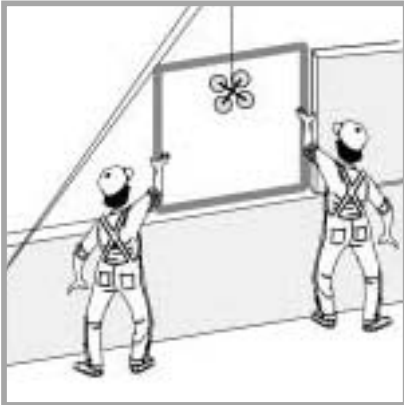
4 Nosta ikkuna paikoilleen.
